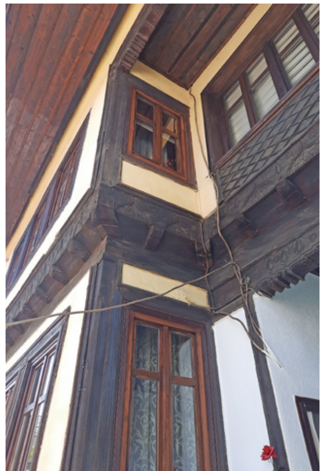
10. Кућа Фета бега, западно крило, детаљ обраде екстеријера и конструкције
